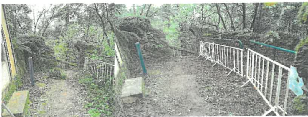
Capela do Horto Via-Sacra antes dos trabalhos (esq.) e depois dos trabalhos (direita)
